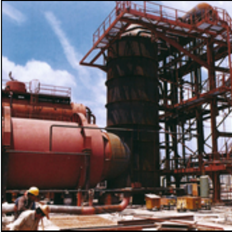
Installation eines Schwefel-Verbrennungsofens mit einem nachgeschalteten Oschatz- Abhitzekessel
