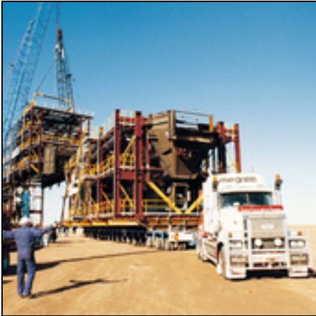
Transport eines vormontierten Schwebeschmelz-Abhitzekessels in Südaustralien
