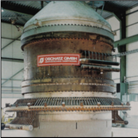
Fertig montiert: NH 3 -Kessel mit Spiralrohr-Heizflächen
